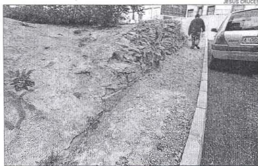
La acera de la calle Mollana está sin asfaltar desde hace mucho tiempo
